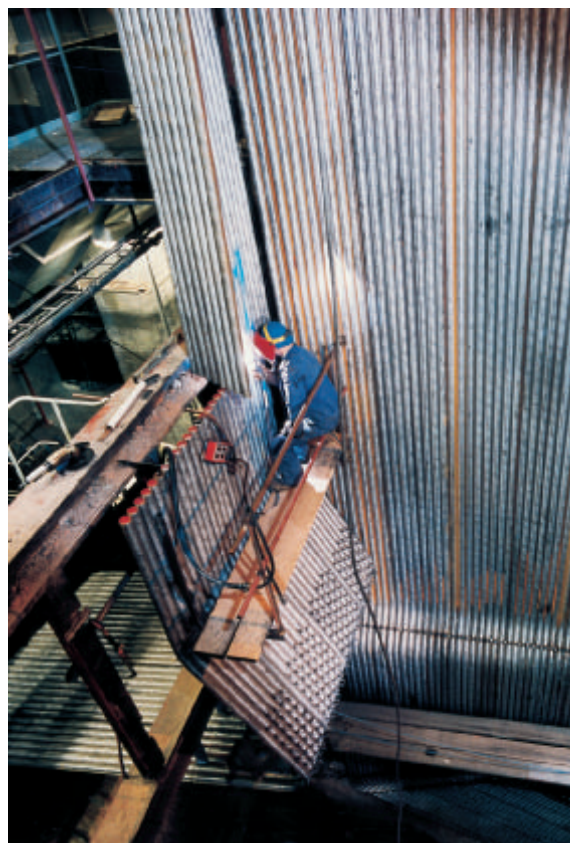
Sandviks kompondrör klarar den aggressivt korrosiva miljön i sopförbränningsanläggningar.
