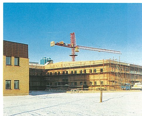
I Gimo pågår en omfattande utbyggnad av anläggningarna.
