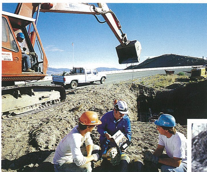
Canada. Claes Wikström hjälper till att borra hål för en ledning under en motorväg i British Columbia.
